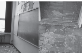
photo.04 唐丹中学校の窓から(2011年7月)
