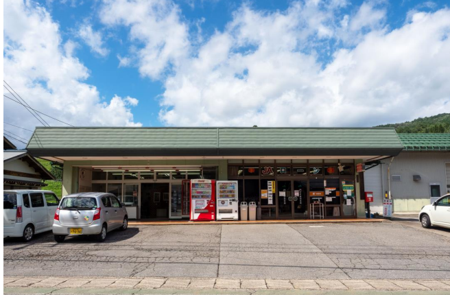
Aコープの空き店舗(建物左側)は地域の人たちの手により憩いのサロンに変身。信包支店(建物右側)はコミュニティ店舗化が決定した
