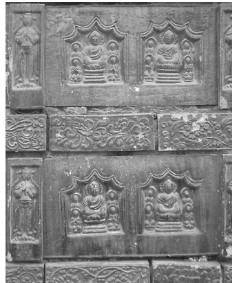
写真44 鉄塔の磁器タイル
