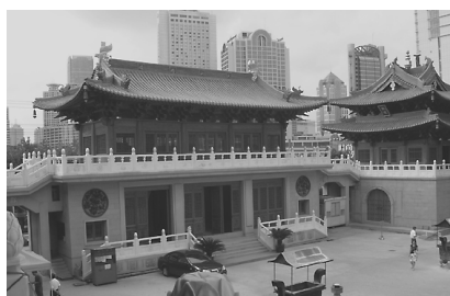
写真118 静安寺山門 (内側から)
