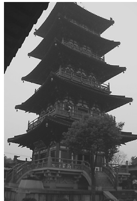
写真4 寒山寺の五重塔 「普明宝塔」
