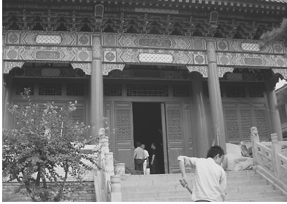
写真103 工事中の地獄堂
